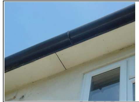
Asbestos soffit
